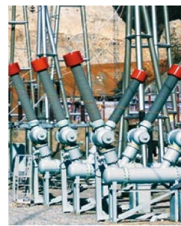
ZHW1-252 复合电器 ZHW1-252 compass of dead tank
