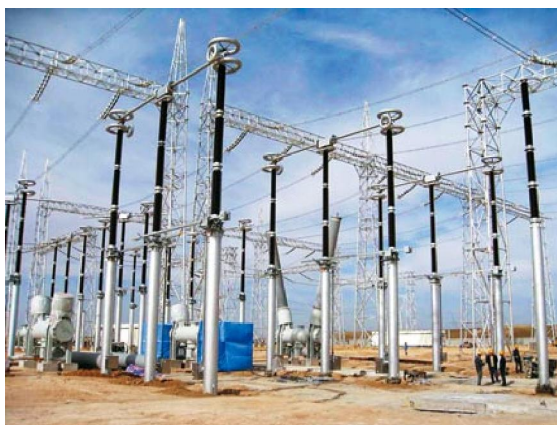
GW27-800 高压交流隔离开关 GW27-800 high voltage AC disconnector
